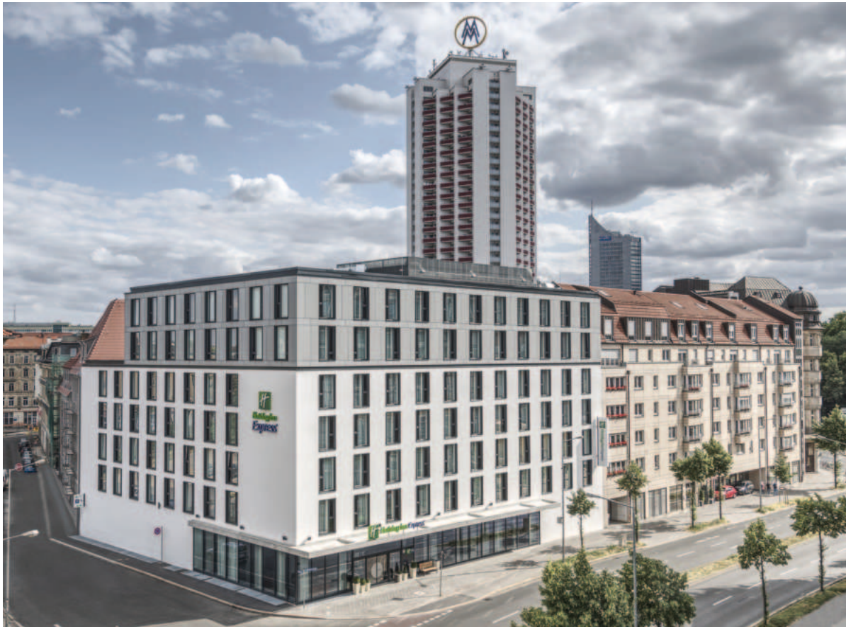
Das Hotel „Holiday Inn Express“ in Leipzig ist ausgestattet mit 125 raumhohen Fenstern in der Farbe anthrazitgrau. Eingebaut wurden das Fenstersystem Matura 76 und das Kastendoppelfenster Matura City, um die hohen Anforderungen an den Schallschutz sowie den Wärmeschutz zu erfüllen.
