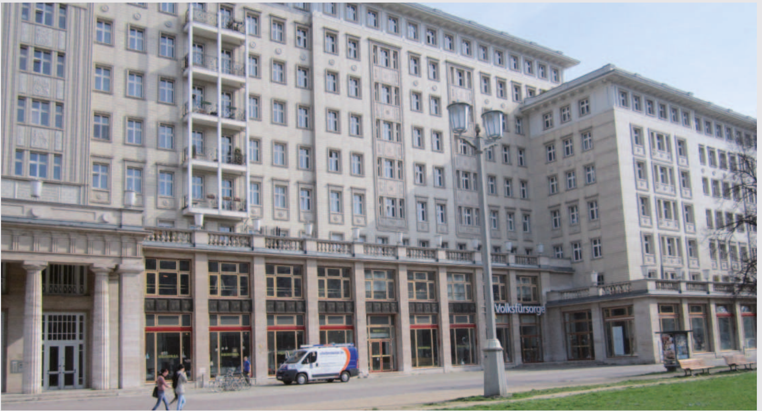
Sanierung von 244 Wohnungen. Eingebaut wurden 1.900 Holzfenster, Modell hilzinger Natura Denkmal IV78 mit Schallschutzklasse 4 zur Straßenseite.
