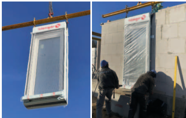
Fenster mit Windowment-Modul wird in die Wandöffnung positioniert.
