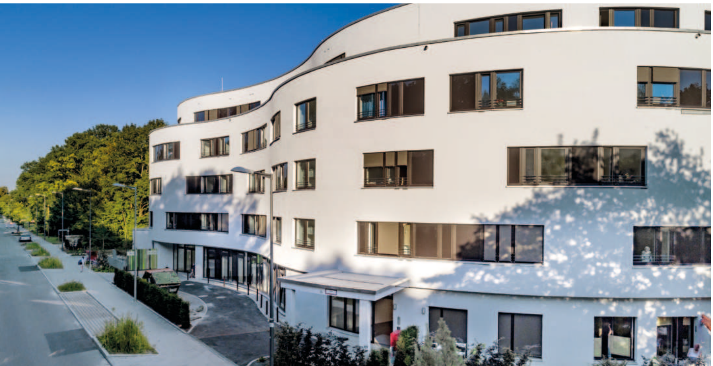
Die Pflegeeinrichtung „AWO-Föhrenpark“ in München ist ausgestattet mit 3-fach-verglasten Kunststofffenstern im System Zenit 76 inklusive Sonnenschutz und Absturzsicherung.
