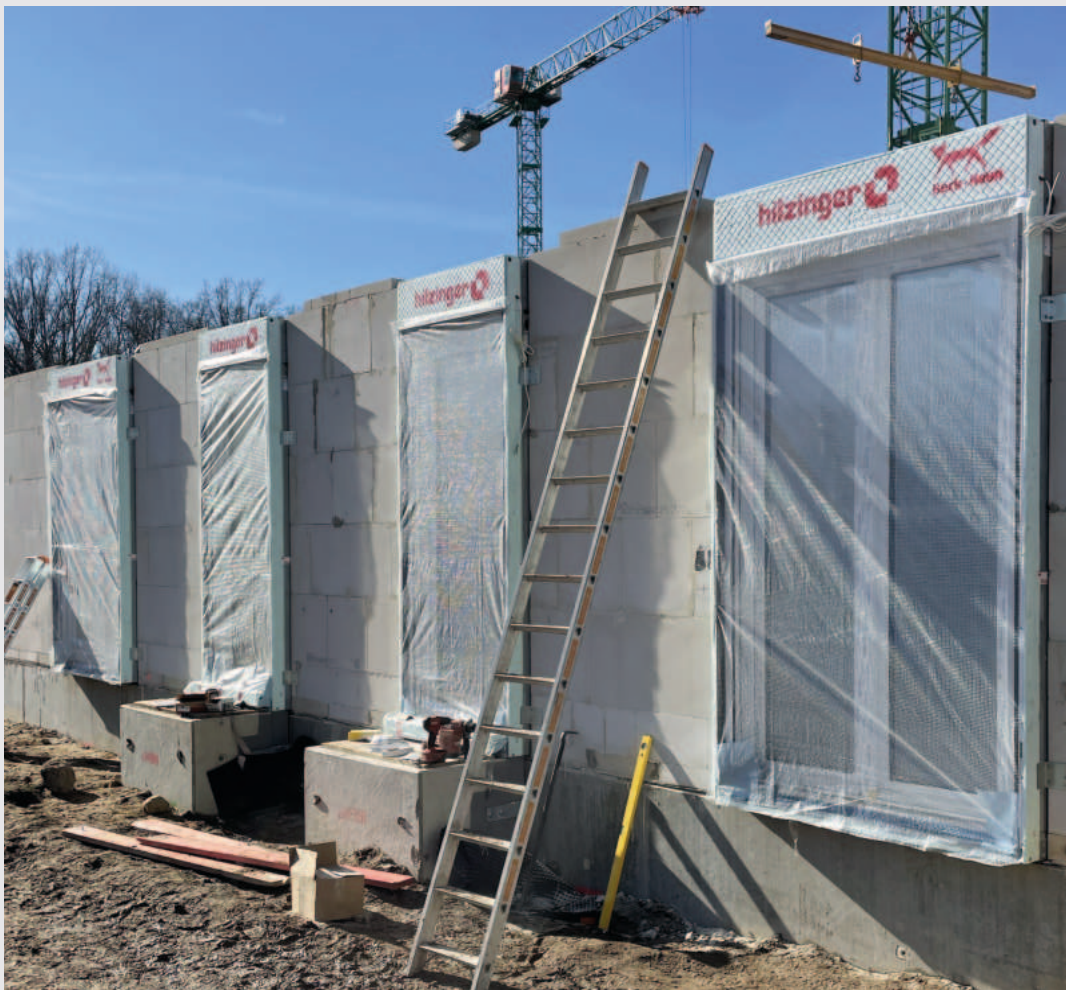
hilzinger WINDOWMENT® fix und fertig ausgeliefert und montiert
