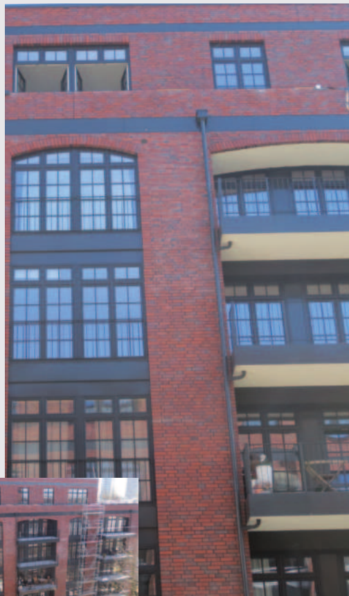
Fenstersanierung in 50 Wohneinheiten in Hamburg. Eingebaut wurden farbige Kunststofffenster mit aufgesetzten Sprossen.
