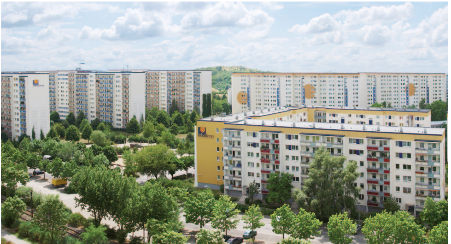
Sanierung eines Plattenbauviertels in Berlin. Eingebaut wurde das Kunststoff-Fenstersystem Solar-ClimaTEC.
